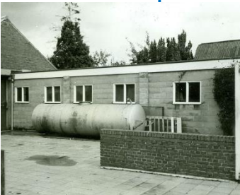
Na de nieuwbouw van de voorraadschuur
