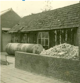
Stoken op petroleum, situatie voor verbouwing aan het Dwarsdiep
